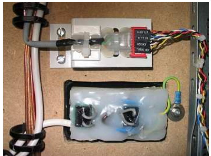
Leitungen verlängert (im Bild oben). Unten sieht man die vergossenen Netzbuchsen mit Erdung der Platte.
