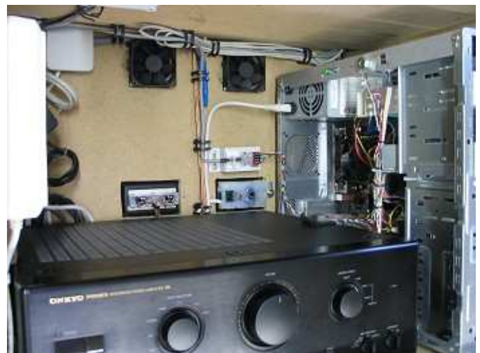
die zweistufige Lüftersteuerung. Abgedeckt wird das Ganze durch die Tür mit dem LED-Schriftzug.
