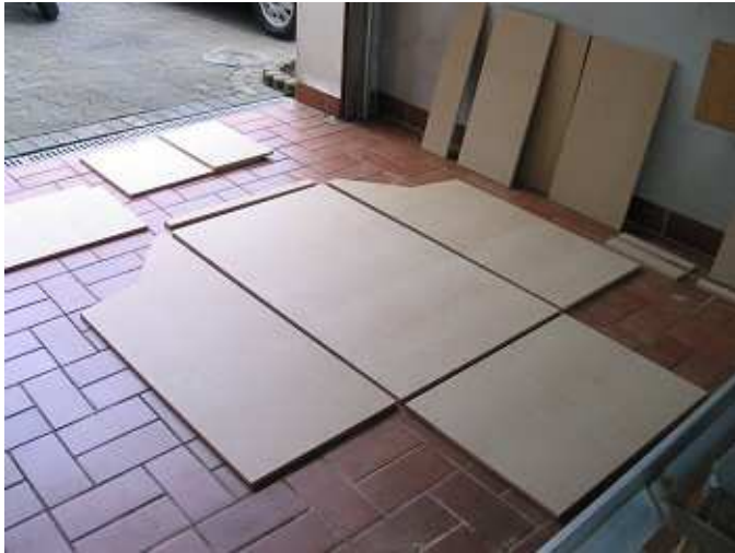
Zurechtlegen und Anzeichnen der Verbindungsstellen
