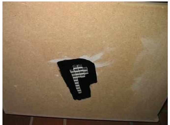
damit das weiße Fugenmaterial nicht durchscheint.
